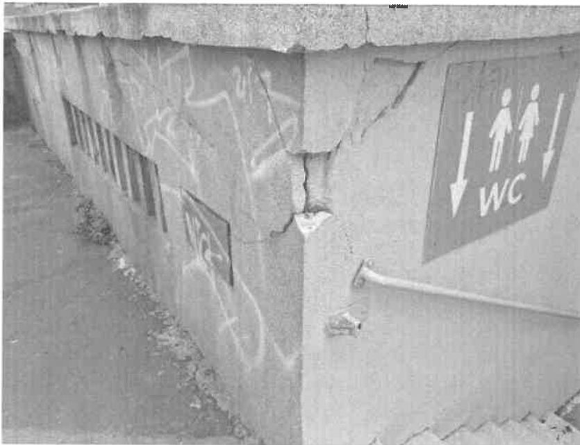
2. fotó: Hálósan repedezett a fal a Tisza Lajos krt-i oldalon
