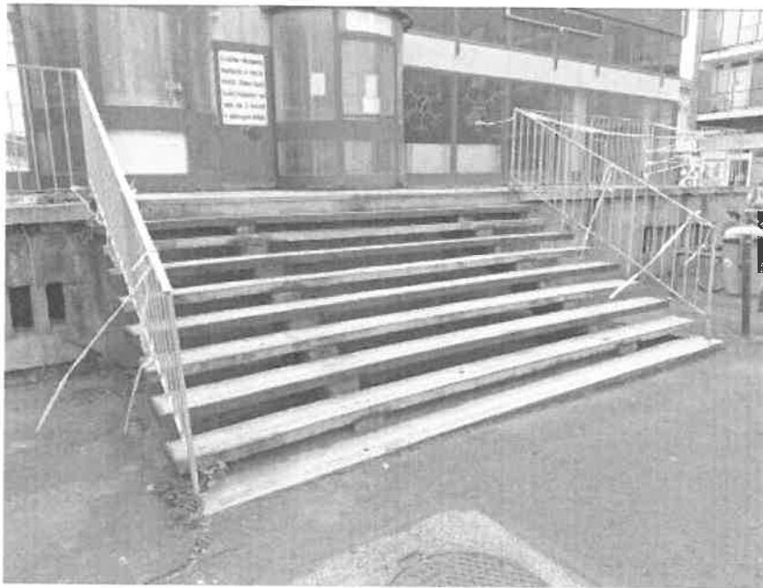
5. fotó: Elbontásra kerülő meglévő lépcső
