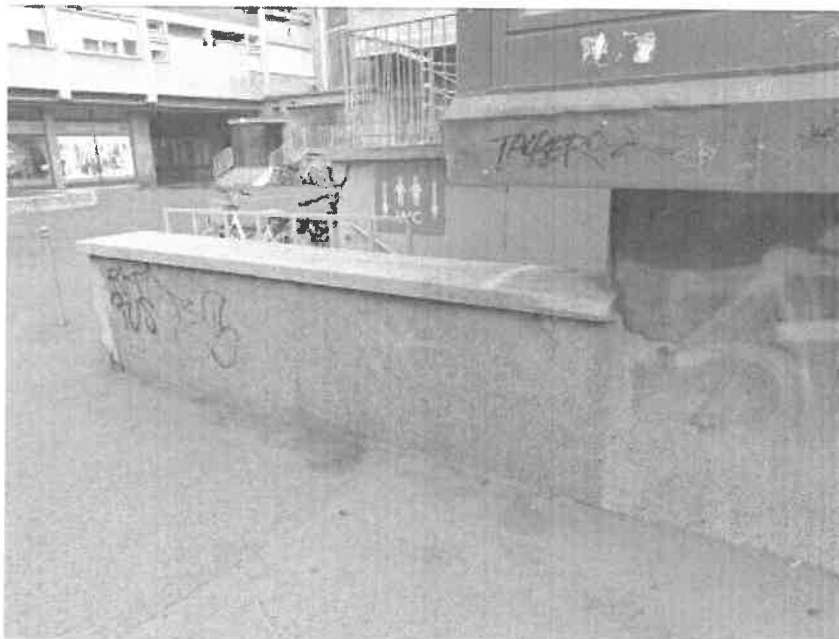
6. fotó: A szintén elbontandó térdfal
