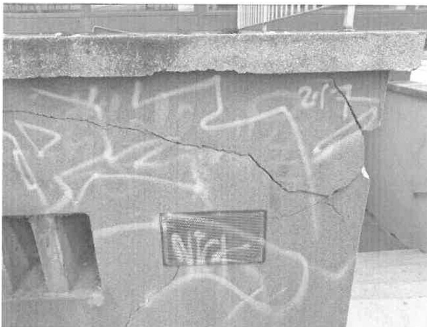
2. fotó: Hálósan repedezett a fal a Tisza Lajos krt-i oldalon
